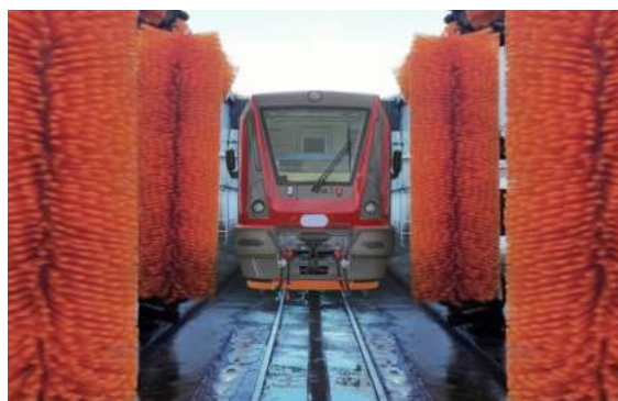
LAVAGGIO TRENI TRAIN WASHING
